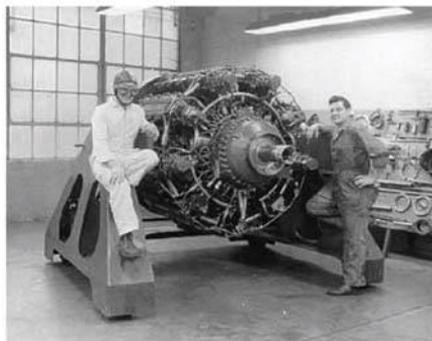
Motore radiale a 36 cilindri
